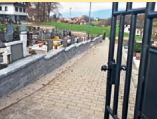
Obnovljena vrata in nova škarpa na pokopališču / Foto: Urška Tepuš
